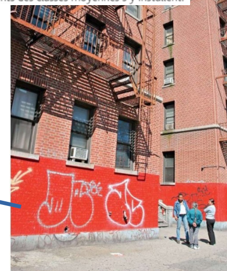
Doc C : Habiter des immeubles collectifs dégradés (manuel Hatier p.204)
