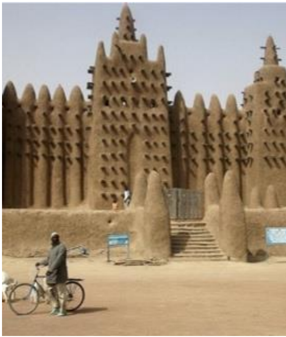
Mosquée de Djenné (XXe siècle), Mali
